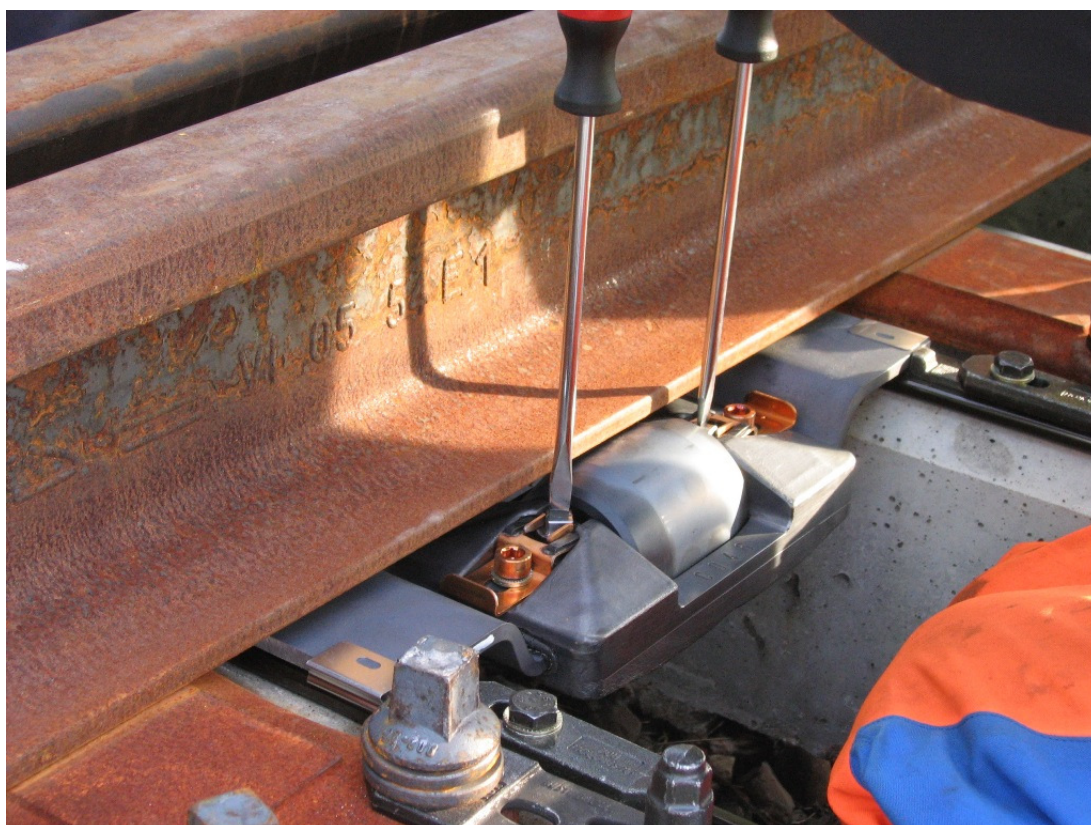
Afbeelding 1: Austroroll (afstellen van de hoogte)
