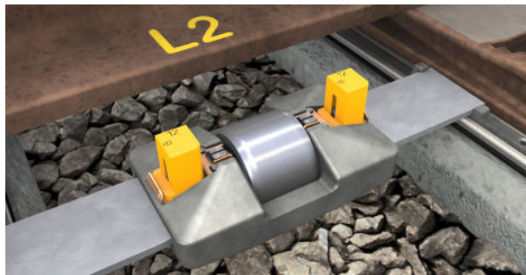
Afbeelding 13: Plaatsen van de afstandsmal H (Mallen geplaatst met 12 mm instelwaarde)
